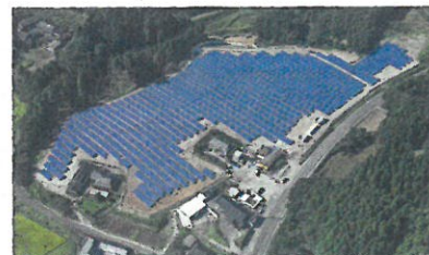
CSJ木場発電所(鹿児島県伊佐市) 1.98MW 2015年
