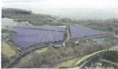
青森県三沢市 2.7MWp 2013年
