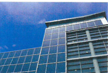
カナダ 30 kWp 2009年
