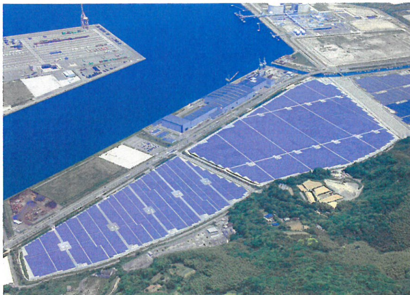
福岡県北九州市 43MWp 2015年
