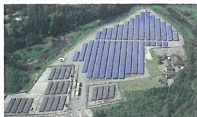
CSJ志布志発電所(鹿児島県志布志市) 1.2 MWp 2015年
