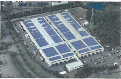
静岡県掛川市 1.5MWp 2013年
