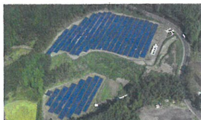
CSJ湧水町発電所(鹿児島県始良郡湧水町) 1.5MW 2015年
