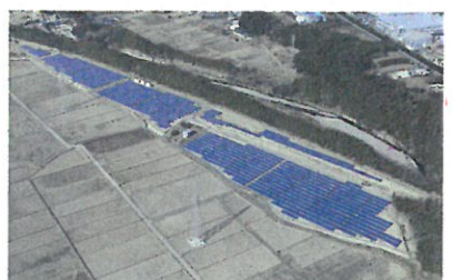
三重県四日市市 2.4MWp 2013年
