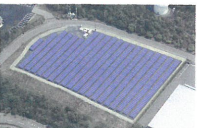
京都府綴喜郡 802kWp 2013年
