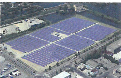
三重県津市 2 MWp 2013年
