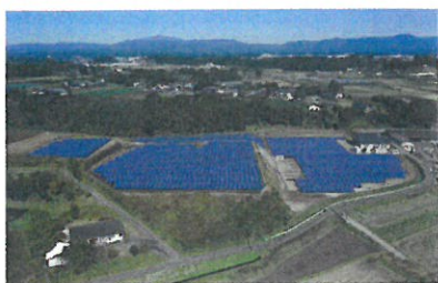
宮崎県西諸県郡 1.3MWp 2014年
