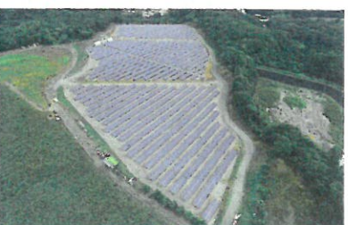
福岡県鞍手郡 2.071MWp 2013年
